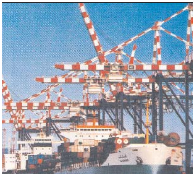
▲ Particolare della banchina del porto di Gioia Tauro durante le operazioni di carico-scarico di alcune navi.
