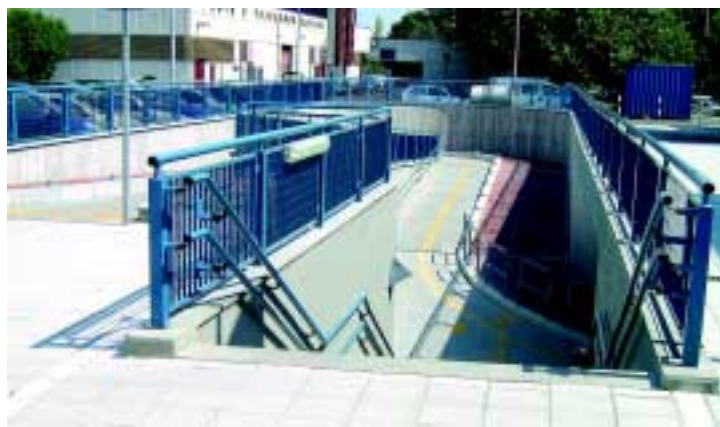
Particolare del sottopasso realizzato presso la stazione Sfm di Borgo Panigale
