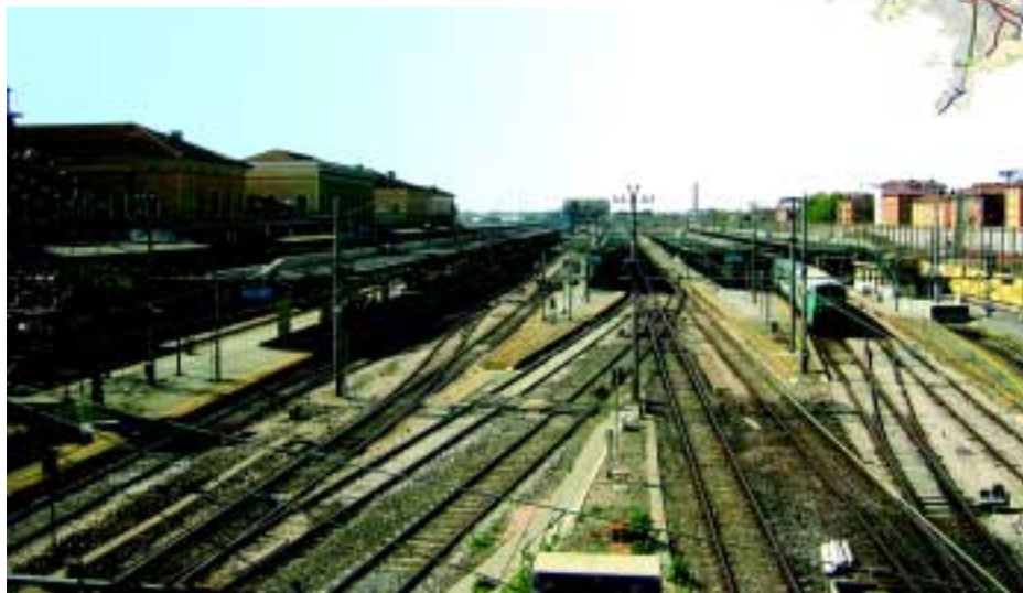
Veduta della stazione attuale, con il fabbricato viaggiatori esistente e, a destra, i lavori per la stazione AV
