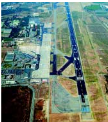
Veduta dell'Aeroporto durante i lavori di ampliamento
