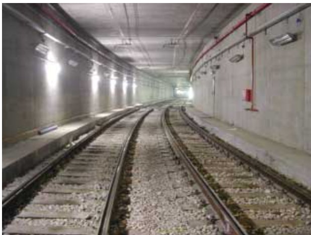
Il tunnel del Tram 4 sotto la ferrovia e l'autostrada
