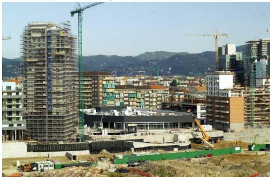
Veduta del cantiere nell'area Vitali della Spina 3
