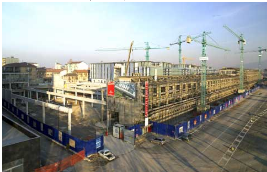
Veduta del cantiere nell'area Savigliano della Spina 3
