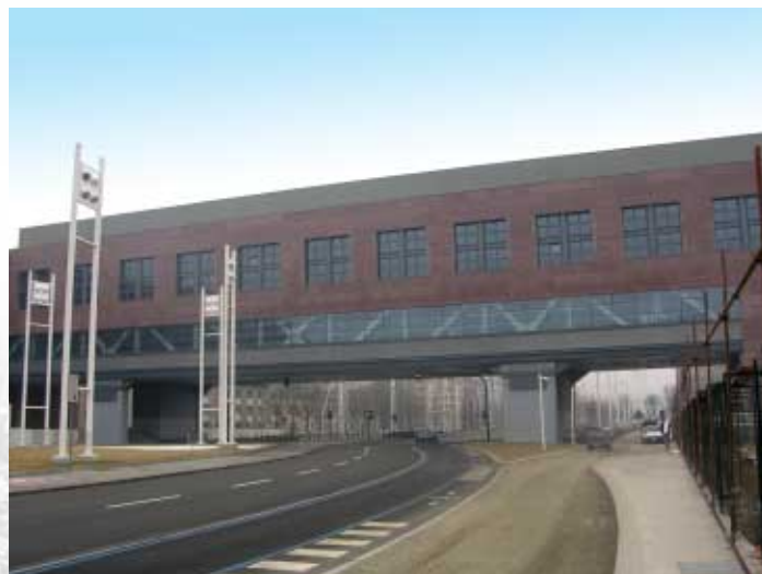
Particolare del nuovo Politecnico della Spina 2
