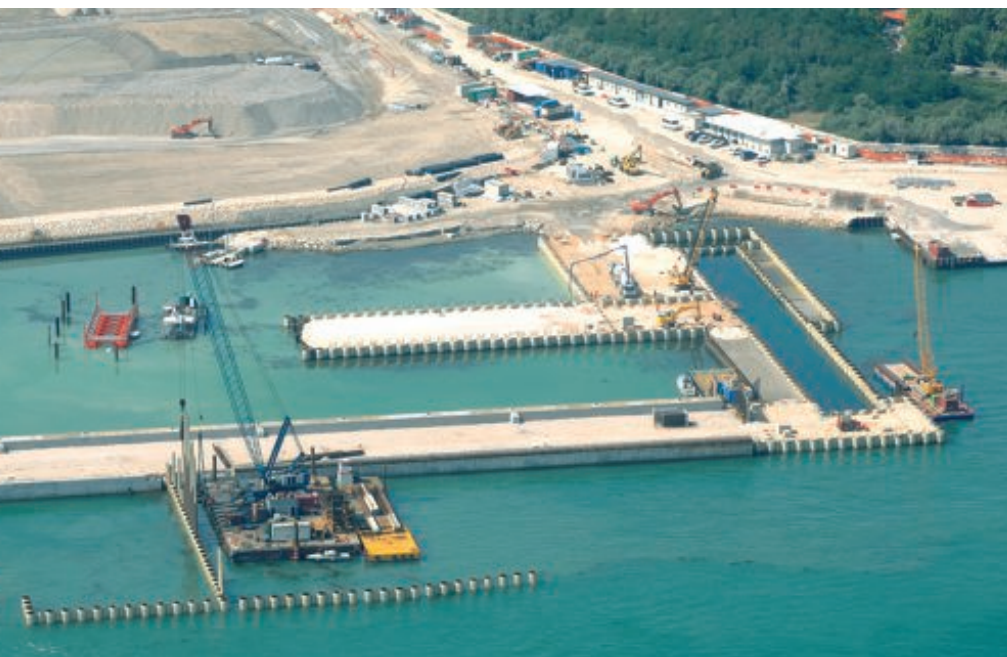
Lavori alla bocca di porto di Malamocco
