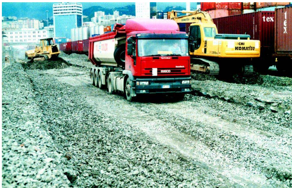
Genova: lavori sul ponte Etiopia
