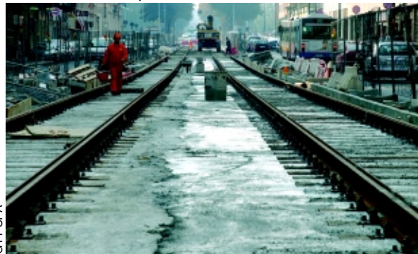
Particolare dei lavori per la linea tranviaria 4
