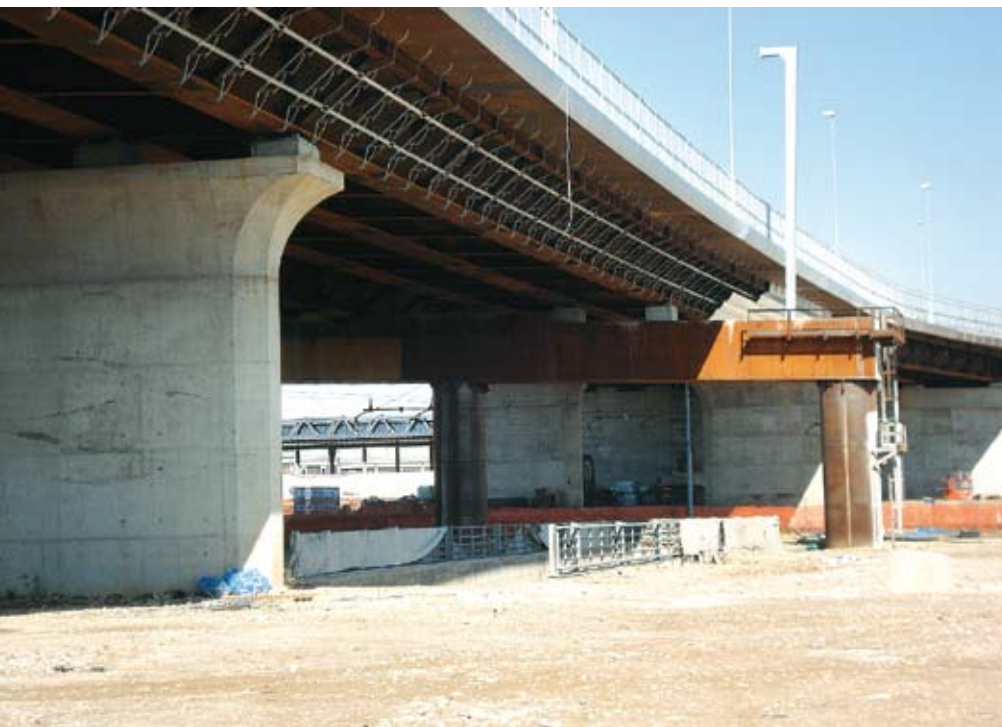
Particolari dello svincolo fra l'area fieristica e l'autostrada A7, completato nel marzo scorso
