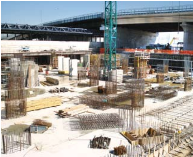
Particolare dei lavori per la stazione AV di Rho-Pero
