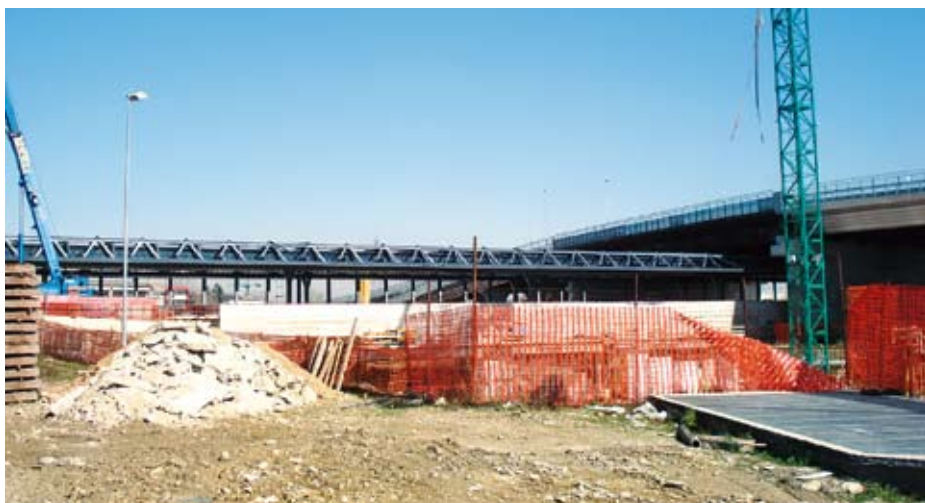
Particolare dei lavori per la stazione AV di Rho-Pero
