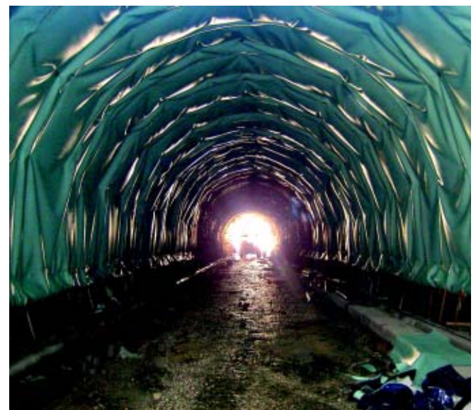
Particolari del consolidamento in superficie e dell'impermeabilizzazione del percorso meccanizzato che attraversa da sud a nord il centro storico di Spoleto
