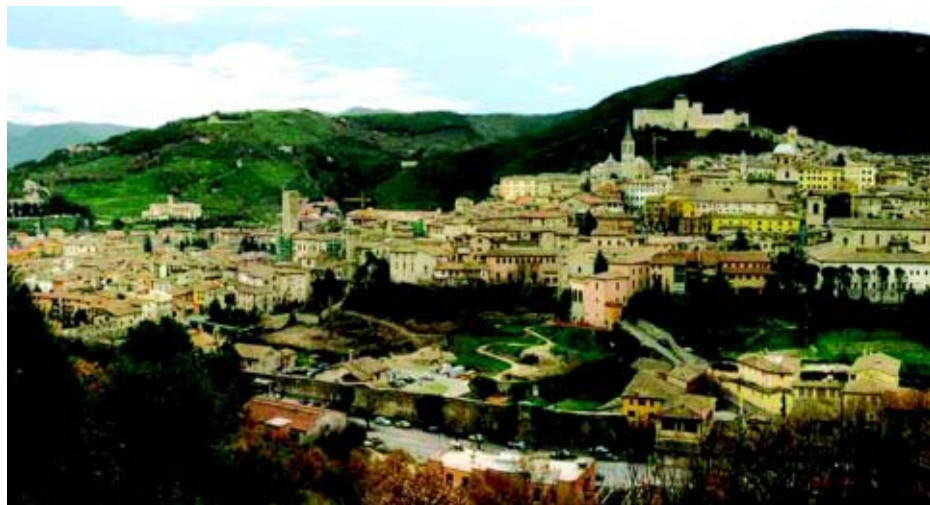
Veduta di Spoleto all'inizio dei lavori di scavo del primo percorso pedonale meccanizzato
