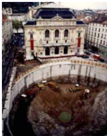
Particolare del cantiere per la costruzione del parcheggio in Place des Celestins, nel centro storico di Lione
