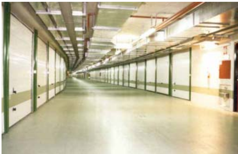
Particolare di uno dei livelli con box per residenti del parcheggio di via Mascagni a Milano
