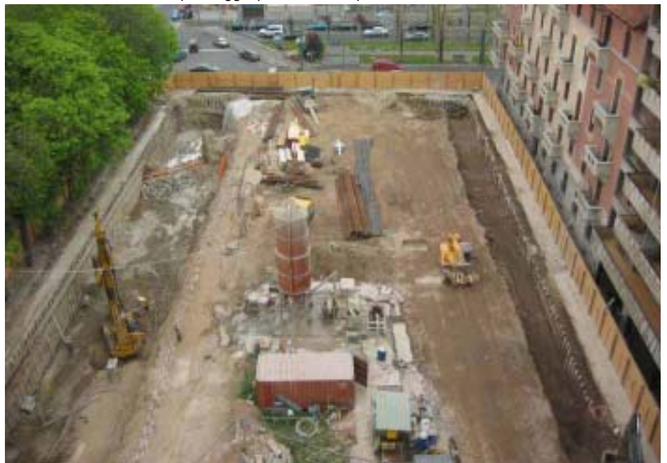
Particolare del cantiere del parcheggio per residenti in piazzale Dateo a Milano
