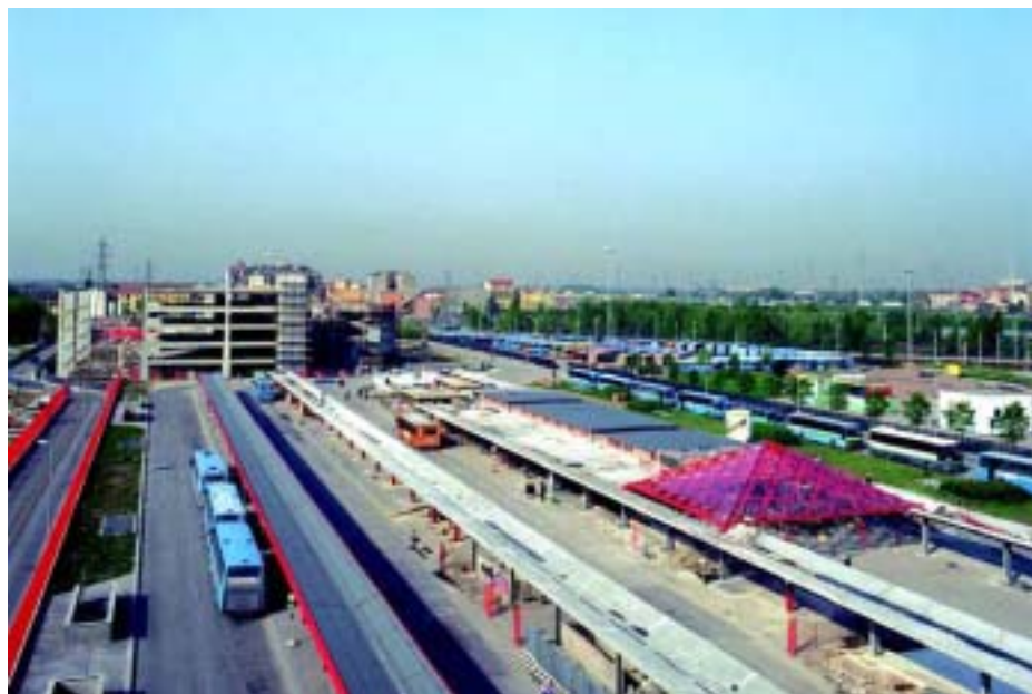
Veduta del parcheggio di San Donato (Milano) d'interscambio con la linea 3 della metropolitana di Milano
