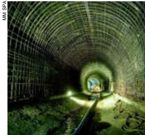
Lavori del prolungamento della metropolitana 2 verso piazzale Abbiategrasso a Milano
