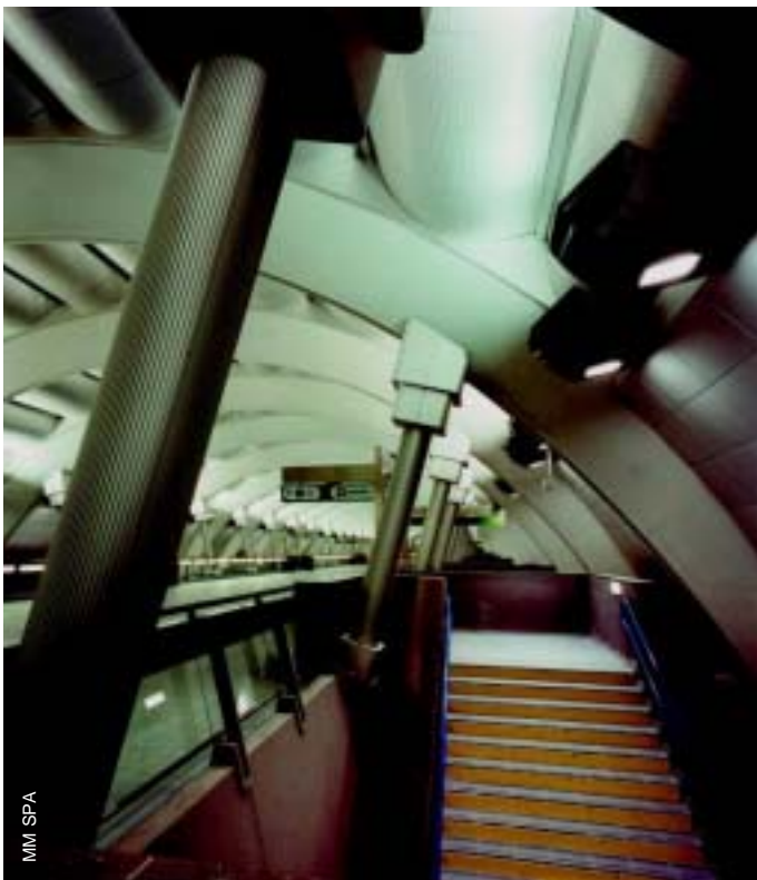
Particolare della stazione di porta Venezia del passante di Milano
