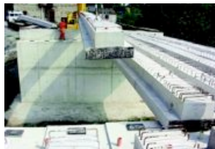
Particolare di un viadotto sulla Statale 80
