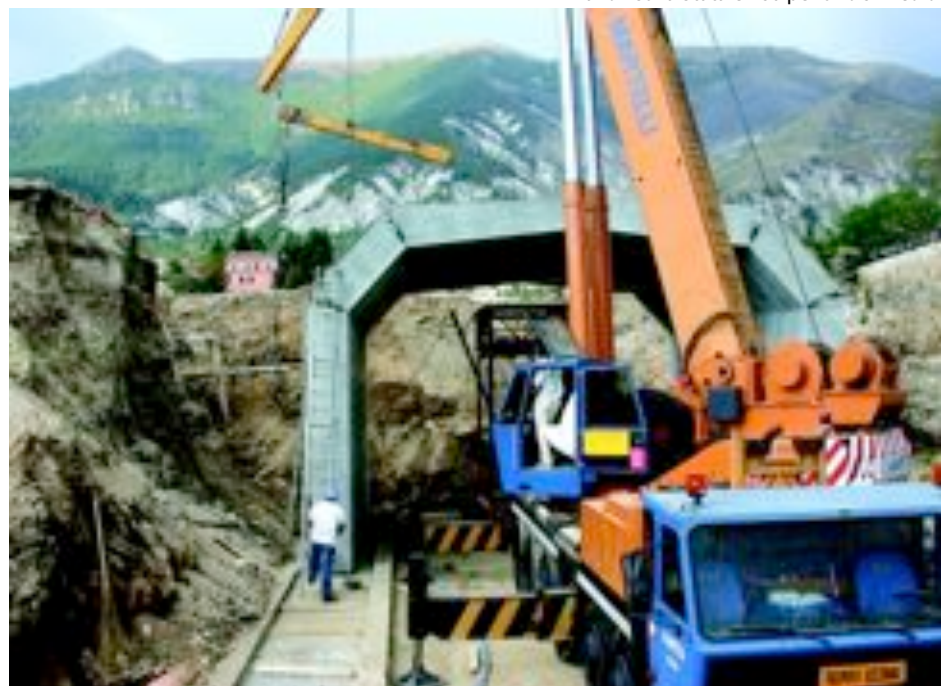
Lavori sulla Statale 260 per uno svincolo
