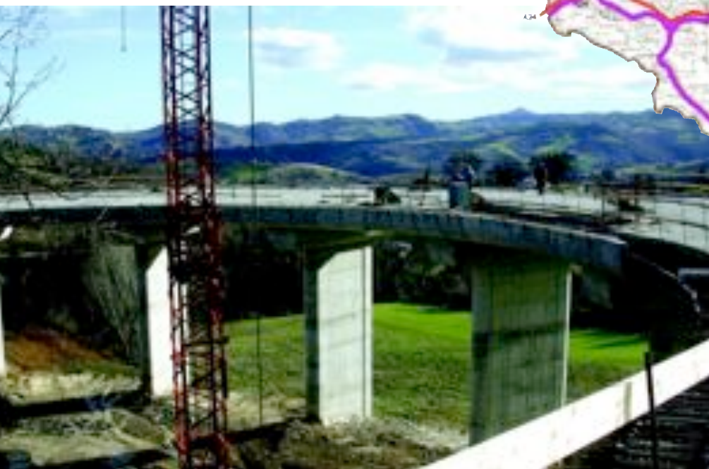
Lavori sulla Statale 491
