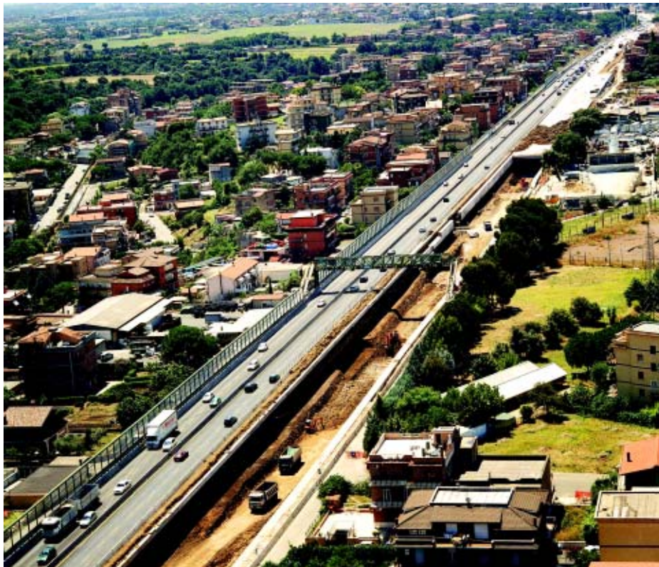
Galleria Selva Candida - Svuotamento galleria artificiale sovrappasso pedonale
