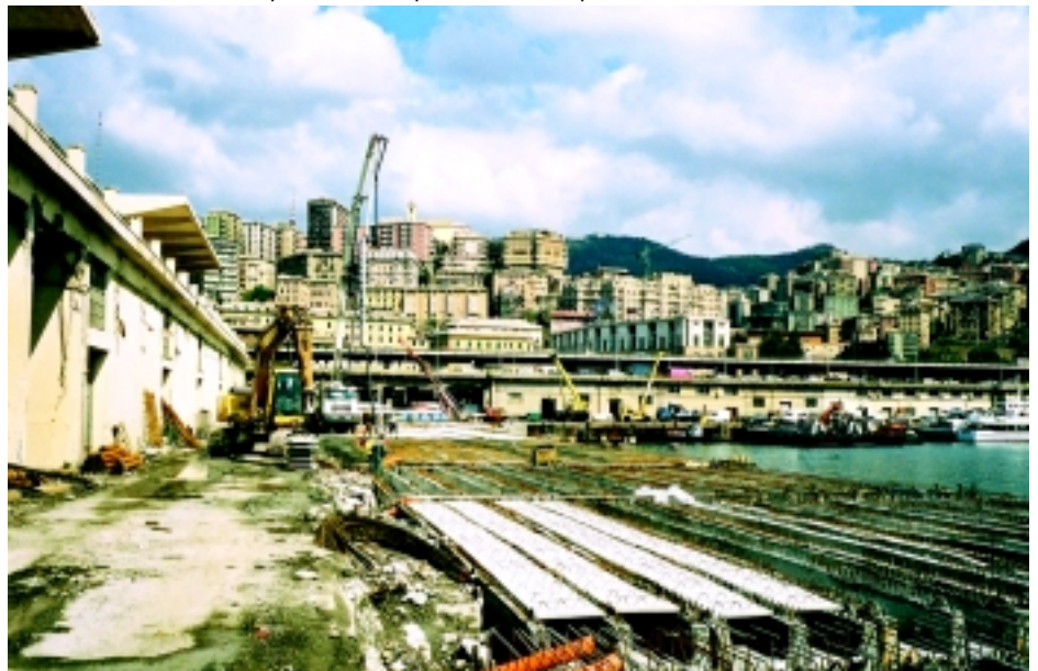
Particolare dei lavori di ampliamento del ponte Doria, nel porto di Genova
