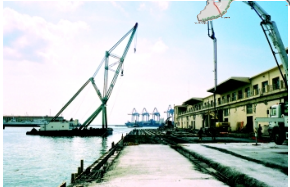
Particolare di lavori di ampliamento del ponte Doria, nel porto di Genova
