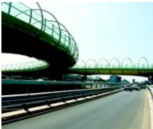
Particolare dello svincolo di piazza Maggi, a Milano
