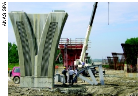
Cantieri del 2° lotto dell'autostrada Asti-Cuneo
