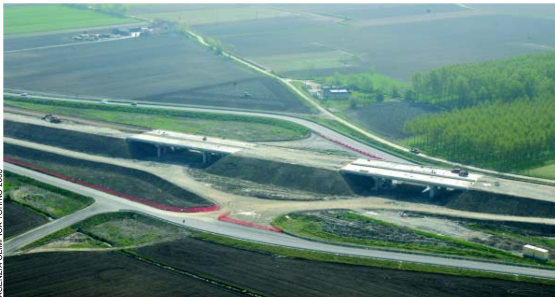
Veduta del cantiere dell'autostrada Torino-Pinerolo
