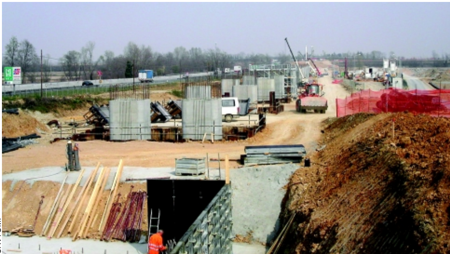
Particolare dei cantieri dell'AV Torino-Novara e della vicina autostrada
