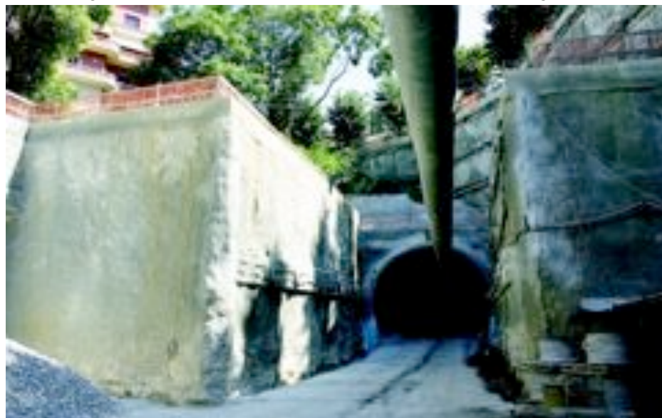
Veduta della galleria del minimetroro scavata sotto il centro storico della città di Perugia
