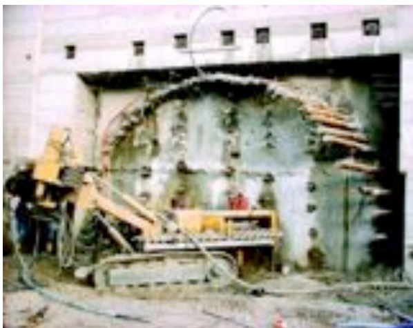
Particolare dell'avvio dei lavori di scavo del percorso pedonale meccanizzato sotto il centro storico di Spoleto
