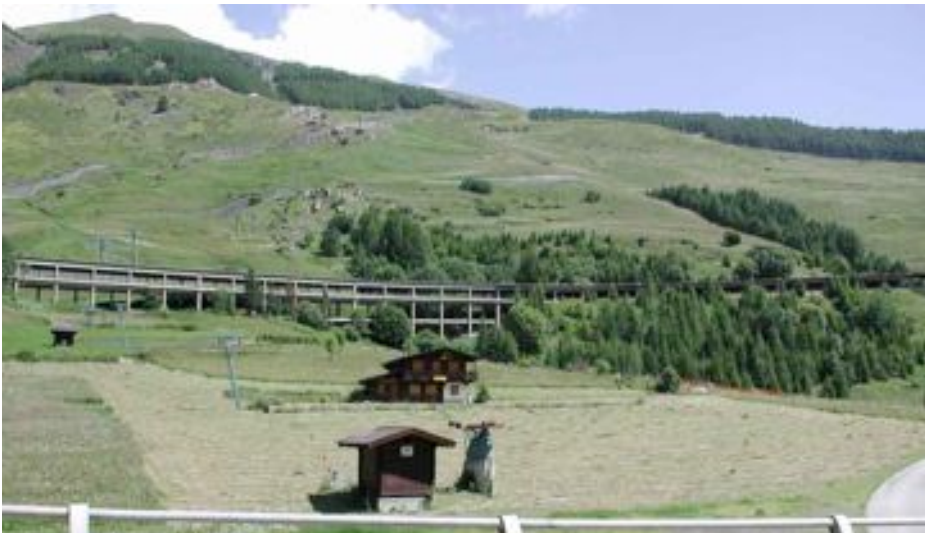
Veduta del viadotto d'accesso al traforo del Gran San Bernardo
