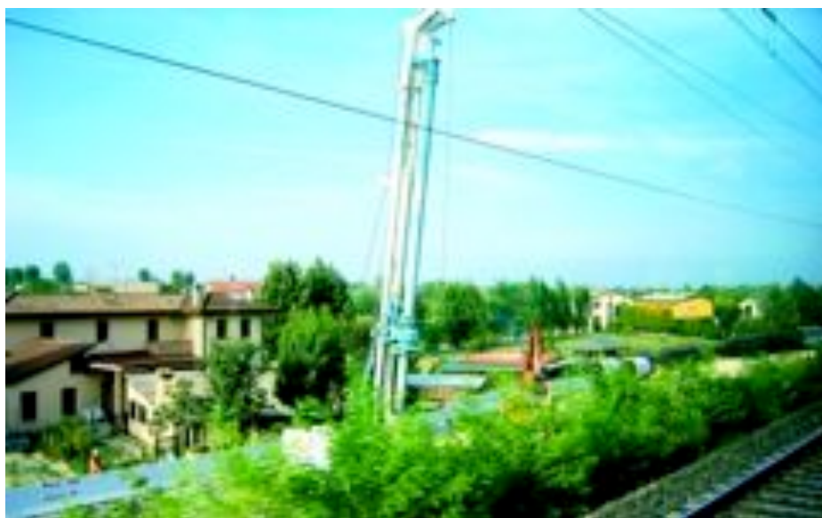
Particolari di lavori sulla Padova-Venezia
