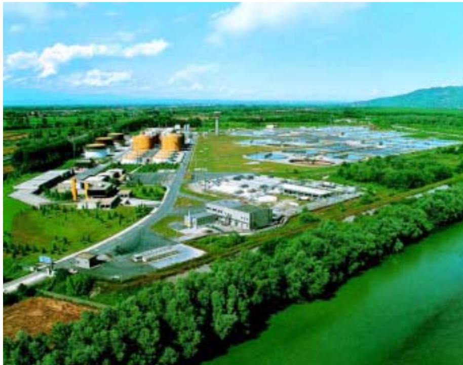
Veduta generale dell'impianto di Torino
