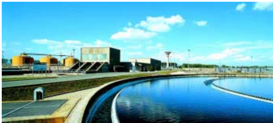
Impianto di depurazione di Torino
