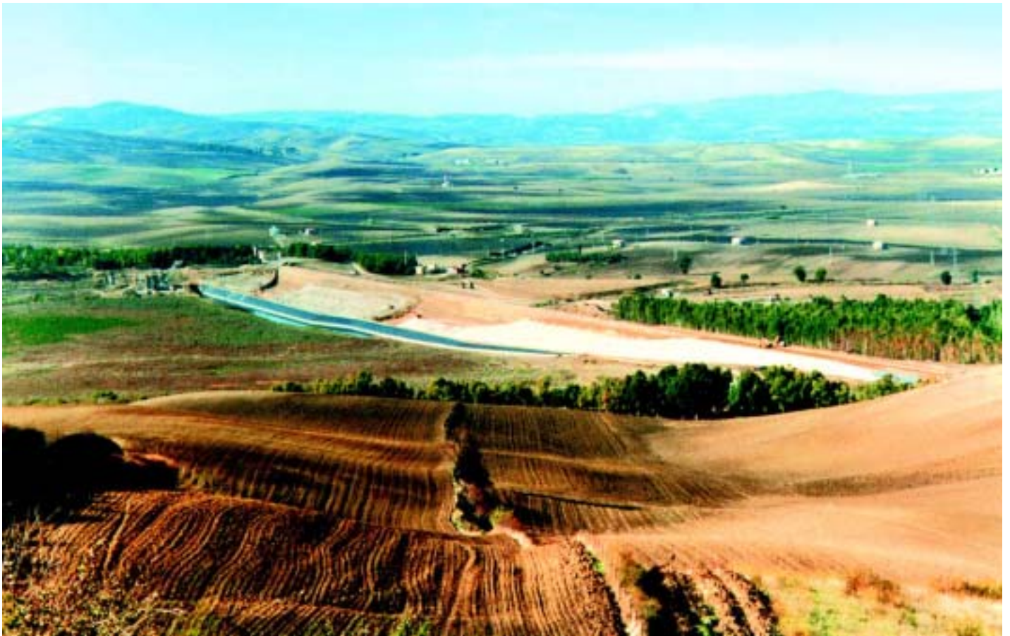
Panoramica della diga del Rendina sul Torrente Olivento - Lavello (PZ)
