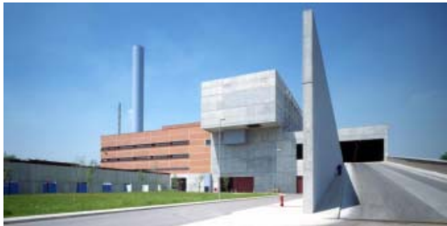
Particolare degli ingressi di Silla2
