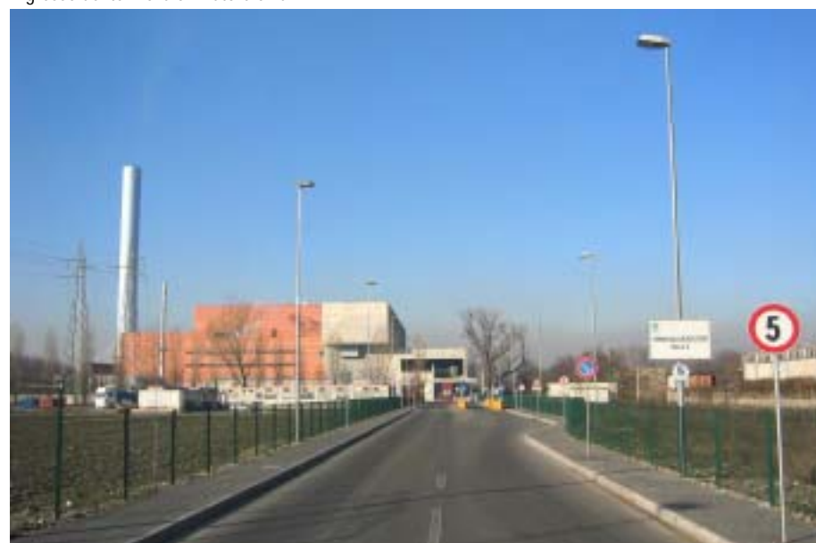
Ingresso del termovalorizzatore Silla2
