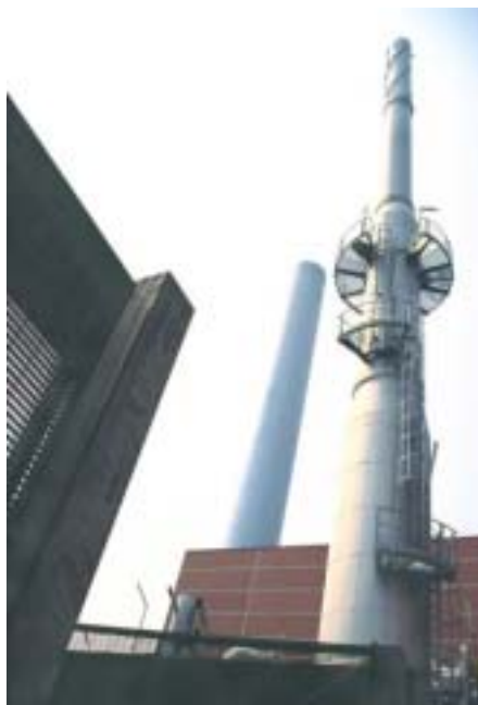
Vista dei camini di Silla2
