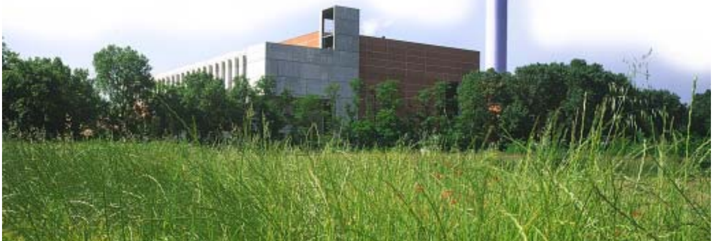
Veduta del termovalorizzatore Silla2 a Milano
