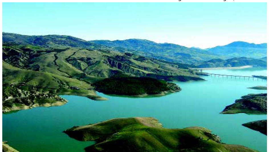
Veduta della diga di Monte Cutogno, in Basilicata
