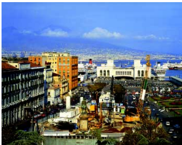
Scavi per il metrò di Napoli, in piazza Municipio
