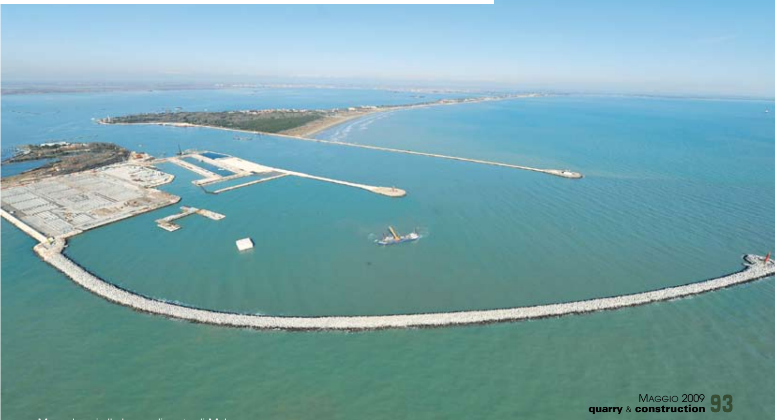
Mose, lavori alla bocca di porto di Malamocco
