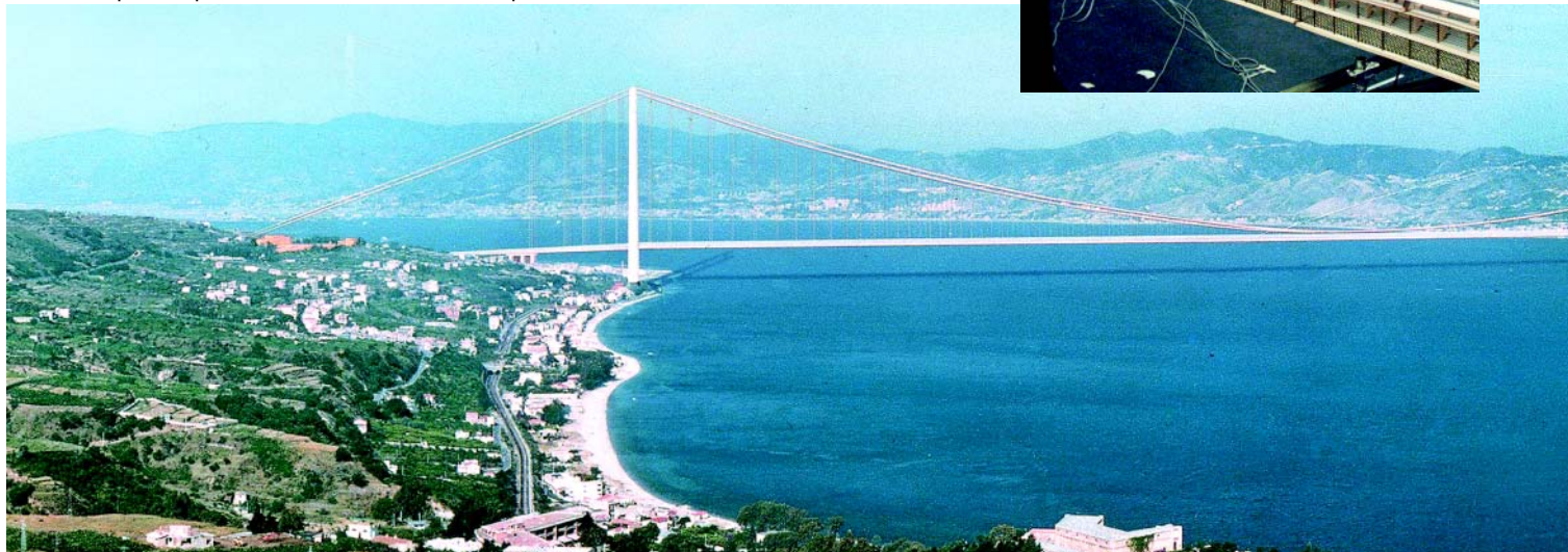
Veduta del ponte e particolare del modello utilizzato per le simulazioni alla Galleria del vento
