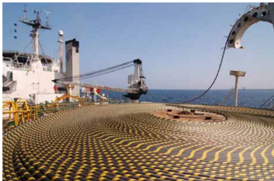
Particolare della nave posacavi che ha realizzato l'elettrodotto Sapei
