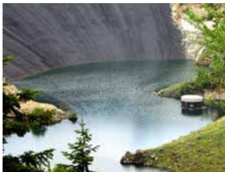
Vista della diga del Menta, in Calabria, oggi in fase di completamento
