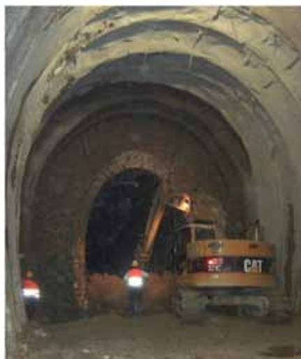
Allargamento della galleria Castellarano, sulla Bologna-Bari, realizzato nel 2008
