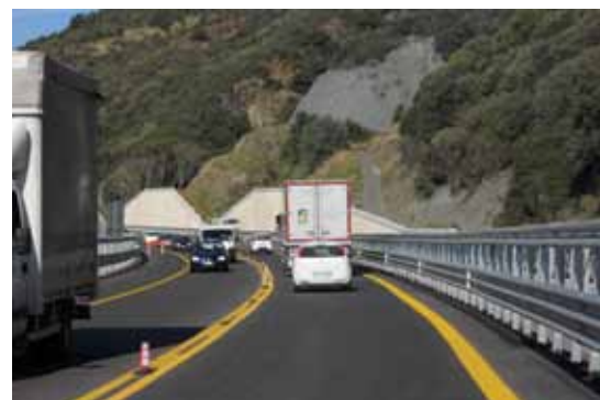
Verifiche prestazionali della pavimentazione di un tratto completato nel 2011 della Salerno-Reggio Calabria
