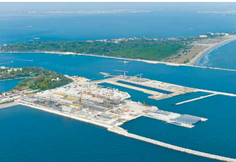
Lido Nord, veduta dell'imbocco e particolare del cassone di spalla già installato
