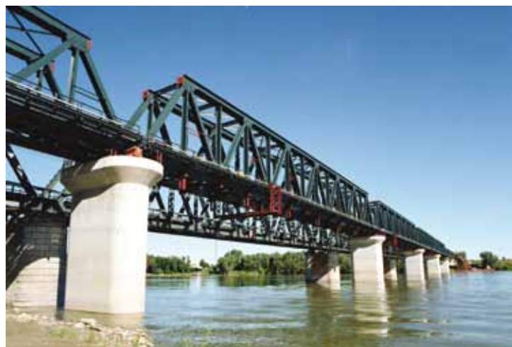
Viadotto di Pontelagoscuro sulla Bologna-Padova
