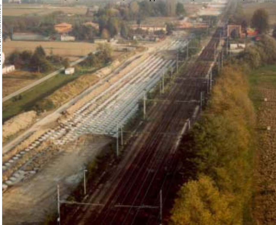
Particolare dei lavori per la realizzazione del rilevato della linea per alta velocità Milano-Bologna, nei pressi di Anzola dell'Emilia
