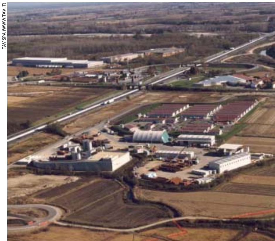
Veduta del Campobase di Greggio dei lavori per la linea per alta velocità Torino-Milano
