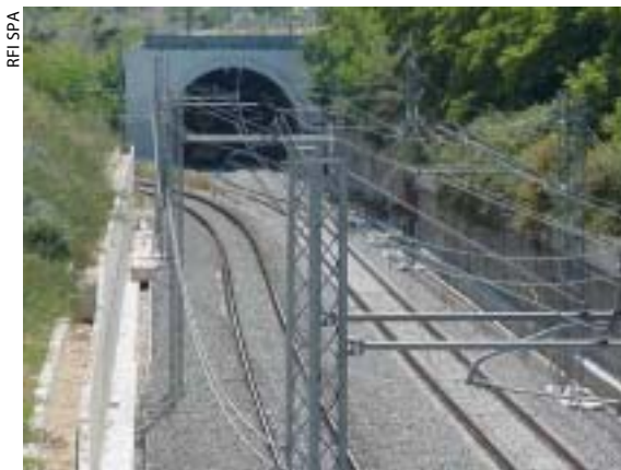
Particolare della galleria di Vasto, parte integrante dei lavori di potenziamento della linea Bari-Pescara, attualmente in corso
