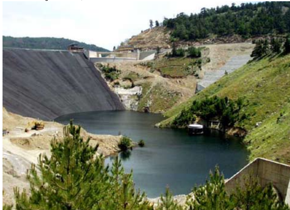
Veduta della diga del Menta, in Calabria
