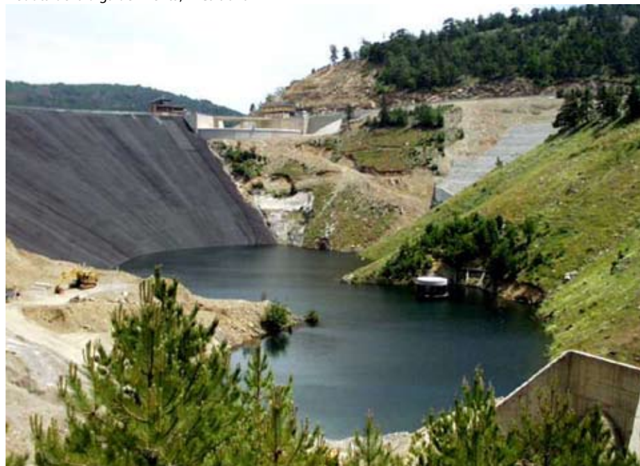
Veduta della diga del Menta, in Calabria
