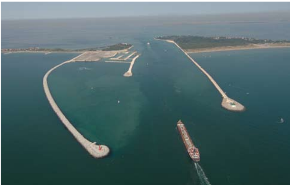
La bocca di Malamocco del Mose in costruzione
