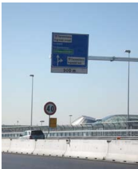
Nuovi svincoli presso il polo esterno della Fiera di Milano
