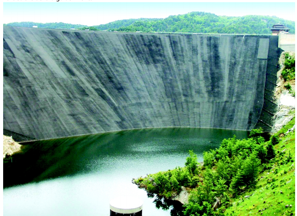
Particolare della diga del Menta
