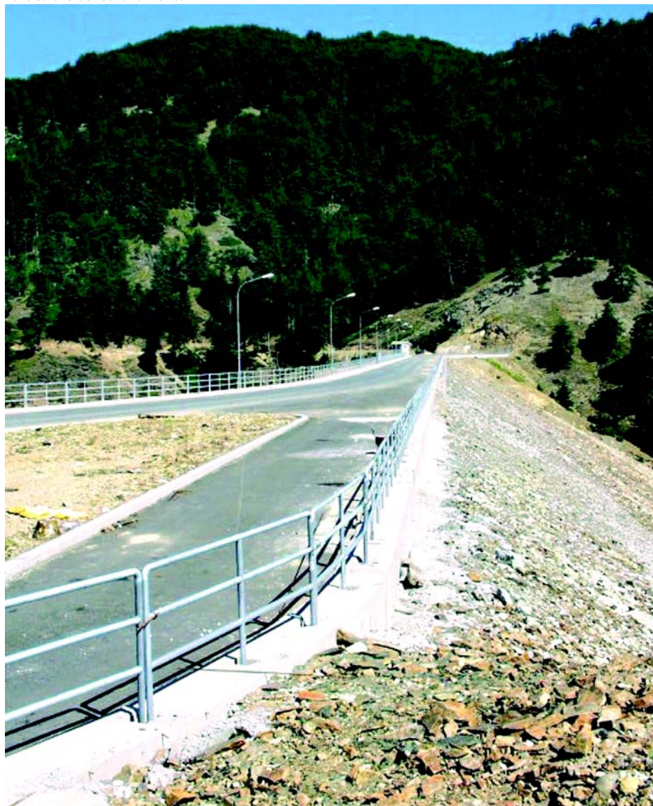
Particolare del coronamento
