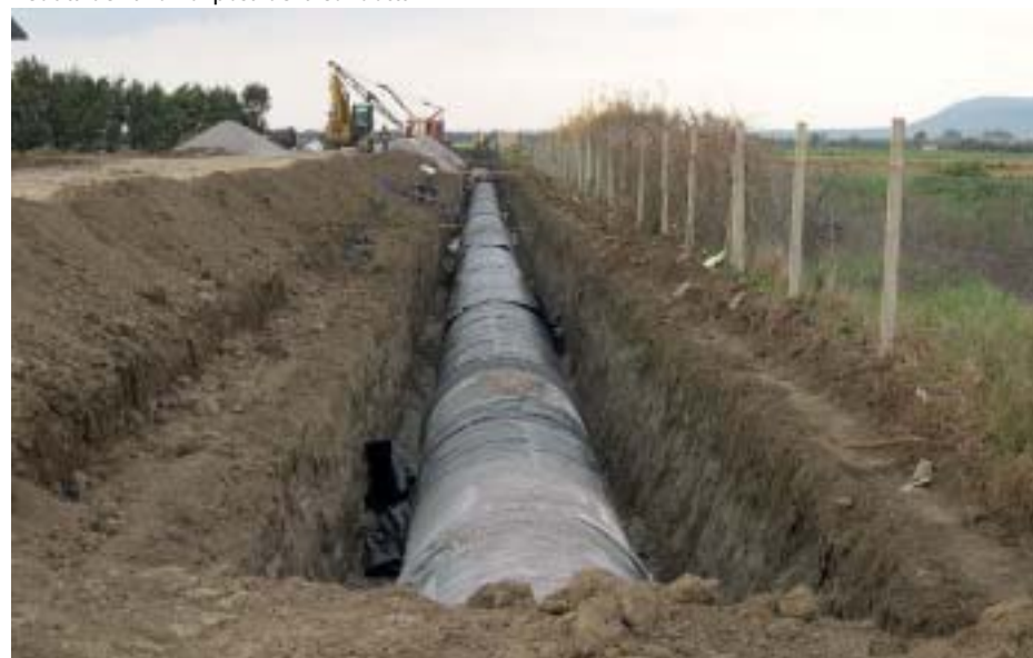
Veduta dei lavori di posa della condotta
