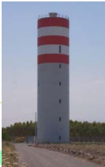
Vista del Torrino di sollevamento Margiani
