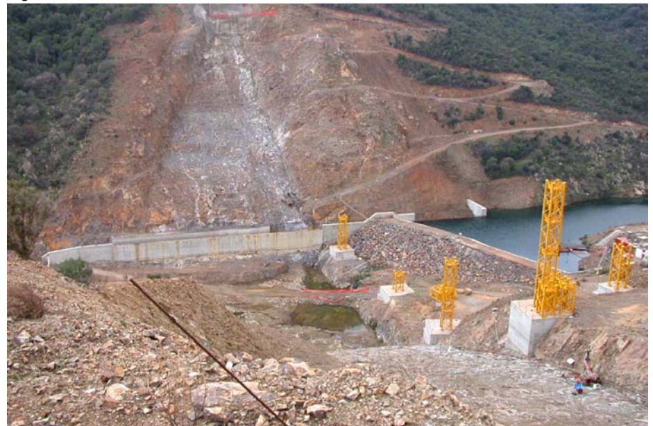
Diga sul Rio Monti Nieddu - Lavori di costruzione
