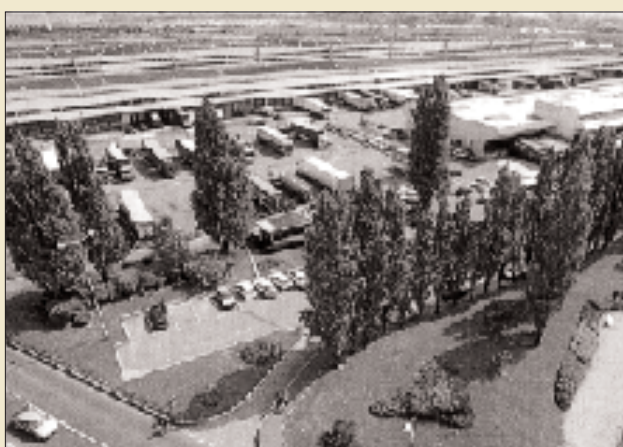
▲ Particolare del parco di attività logistiche di Aulnay-sous-Bois.
