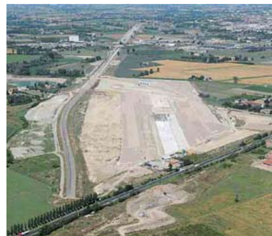
Veduta dello scalo di Marzaglia in costruzione
