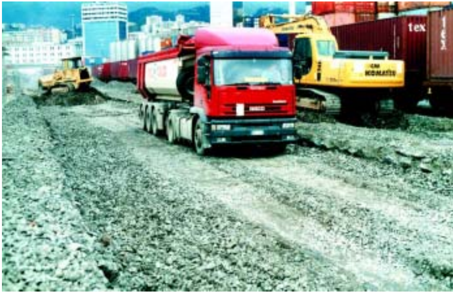
Genova: lavori sul ponte Etiopia
