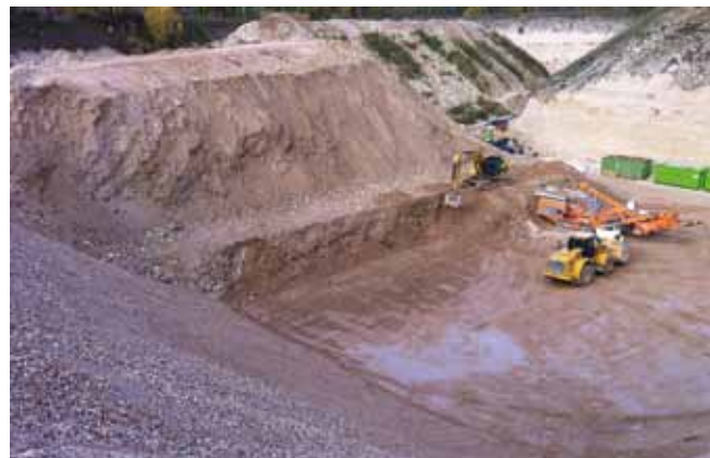
Particolare dell'ex cava Teges, già in fase di ripristino con le macerie del terremoto
