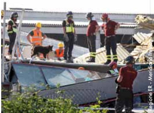
Intervento di soccorso presso i capannoni dell'azienda Haemotronic di Medolla (MO) all'inizio di Giugno 2012
