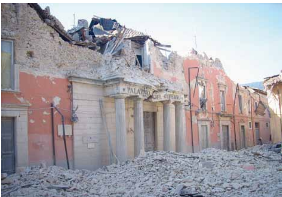
La sede della Prefettura dell'Aquila, nel centro dell'Aquila, completamente distrutta dal sisma
