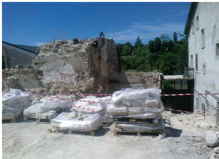
Pietre di pregio rinvenute all'Aquila durante la selezione delle macerie, protette e lasciate in cantiere per il riutilizzo nella ricostruzione dell'edificio
