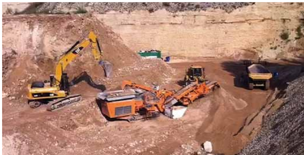
Operazioni di tritovagliatura all'ex Teges, che dopo l'ultima selezione trasforma gli inerti in polvere fina e materiale da ripristino ambientale
