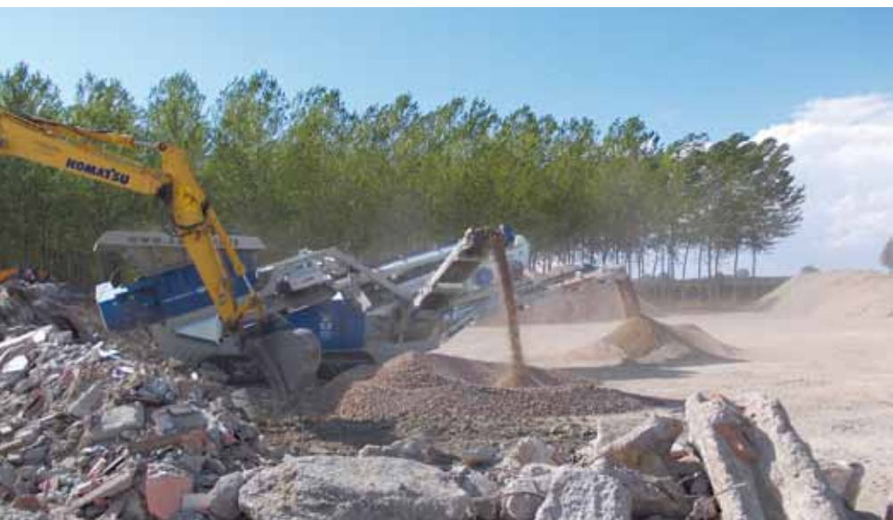
Particolare del Centauro 100.32 di Cams impegnato nella frantumazione e vagliatura delle macerie del terremoto presso un sito privato di Mirandola (MO)
