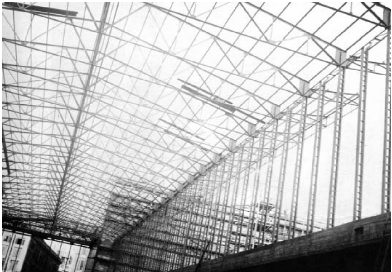
Realizzazione della copertura della "Galleria gommata", 1949
