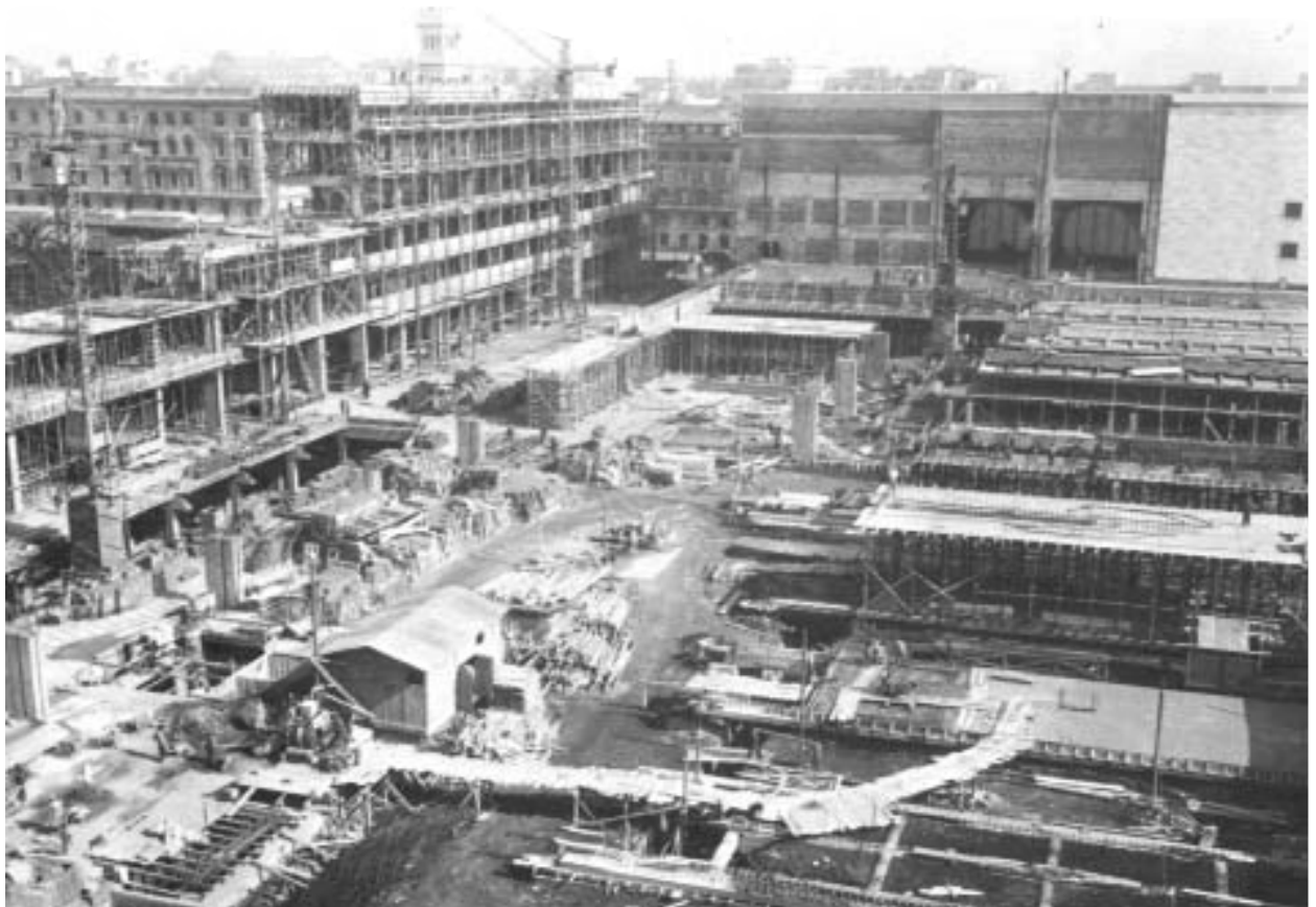
Il cantiere della stazione nel 1949
