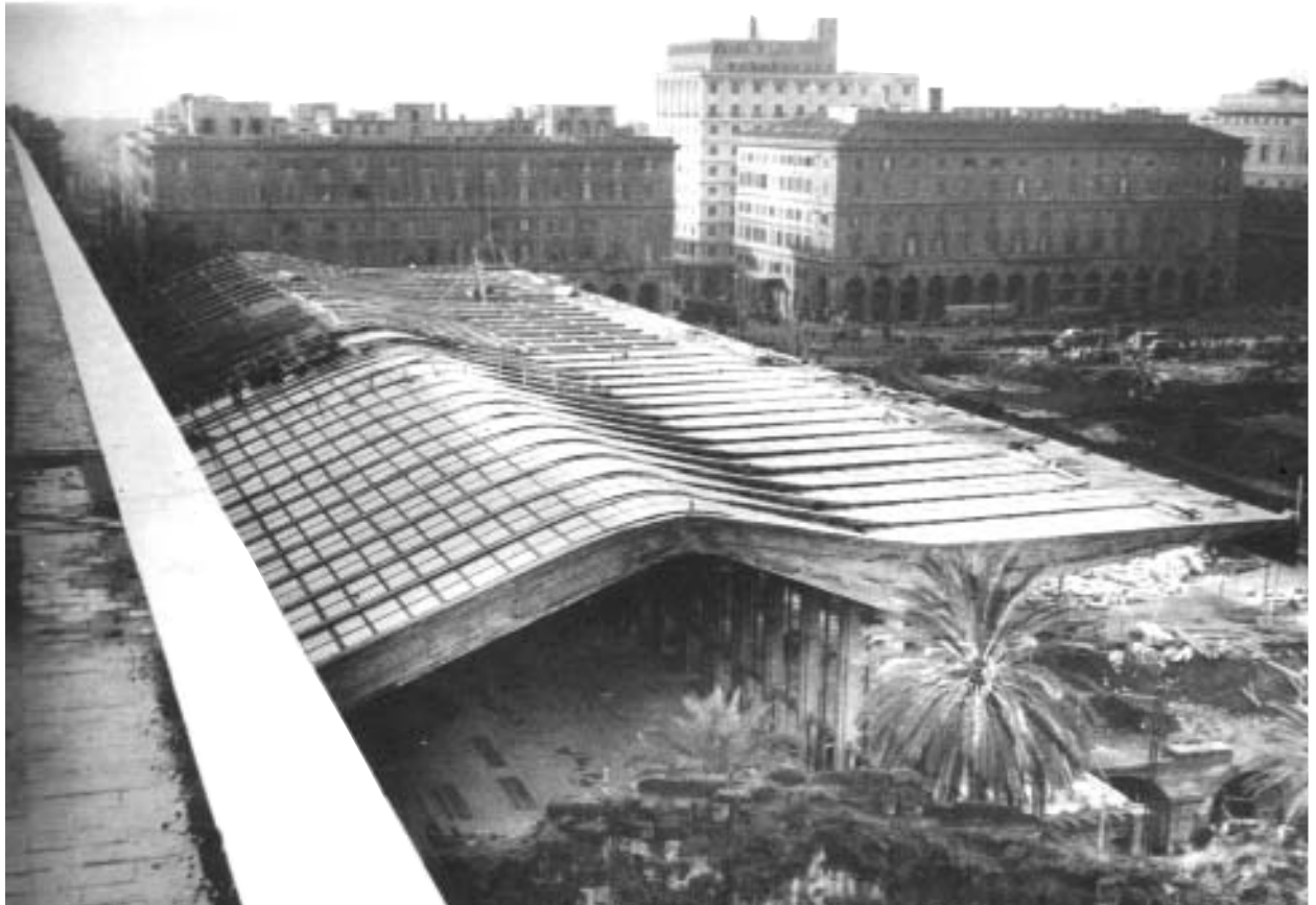
Completamento della copertura dell'atrio biglietteria, 1949
