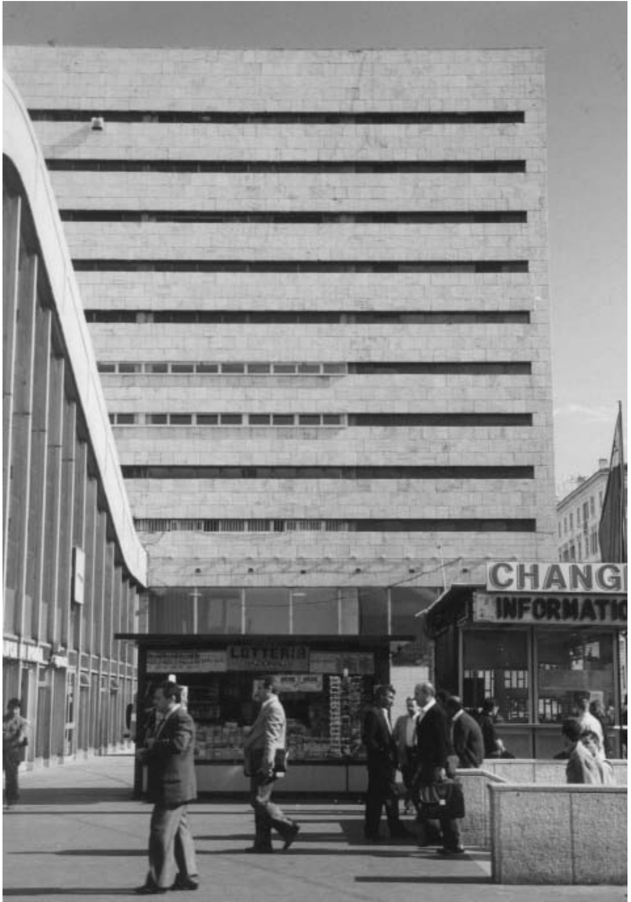
Particolare dell'Edificio E della stazione Termini di Roma, con il lato su via Giolitti del grande atrio biglietteria
