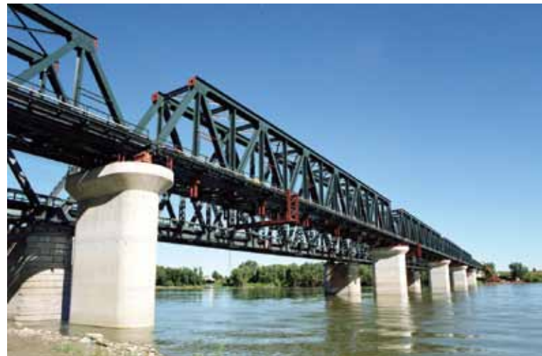
L'attraversamento del Po della ferrovia per Venezia, con il vecchio ponte ammodernato e il nuovo che nel 2006 completa il raddoppio della linea
