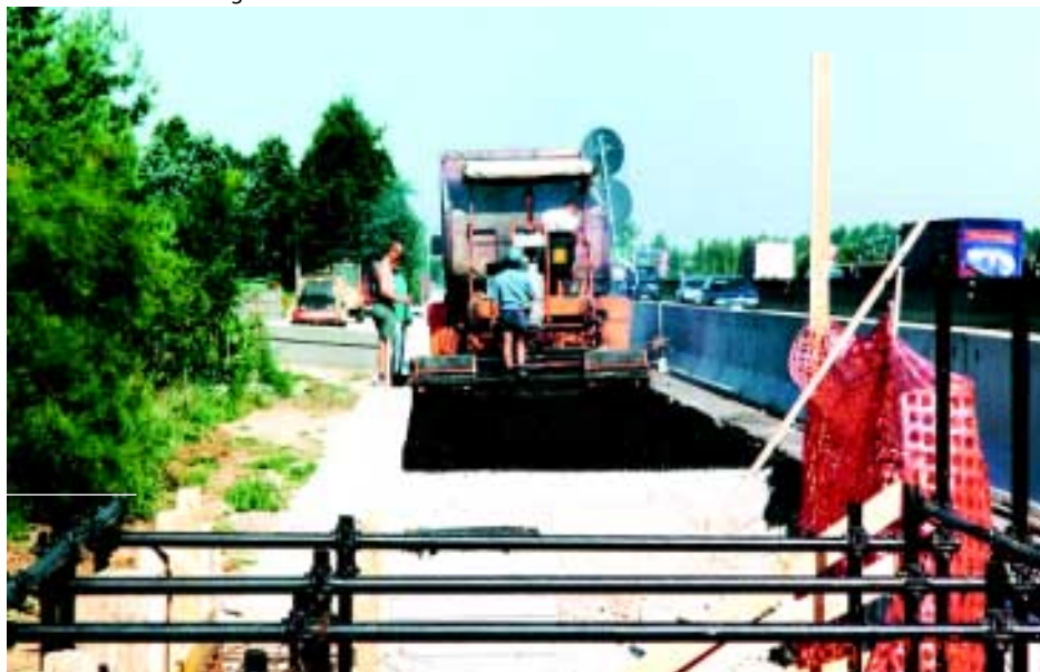
I lavori sulla Milano-Laghi
