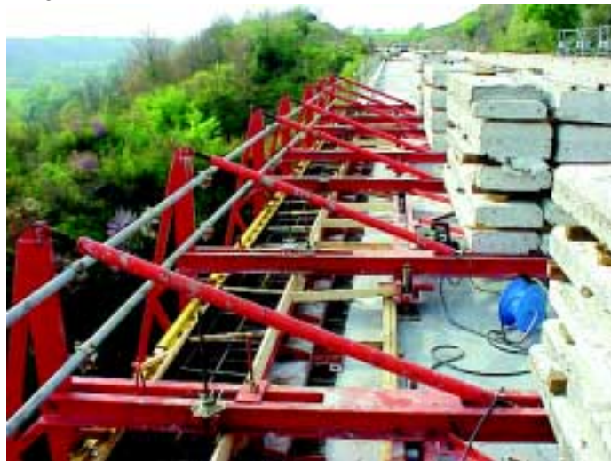
Allargamento di un viadotto sulla Orte-Roma
