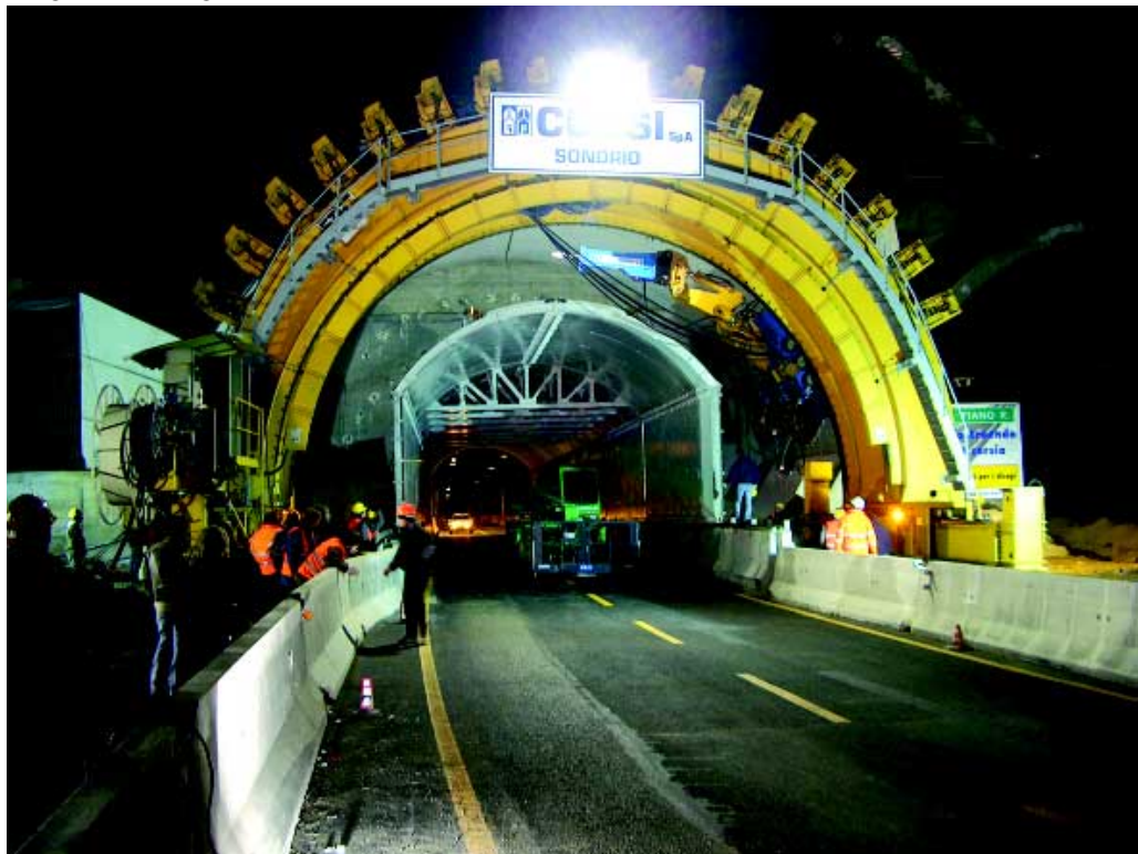
Allargamento della galleria nord di Nazzano
