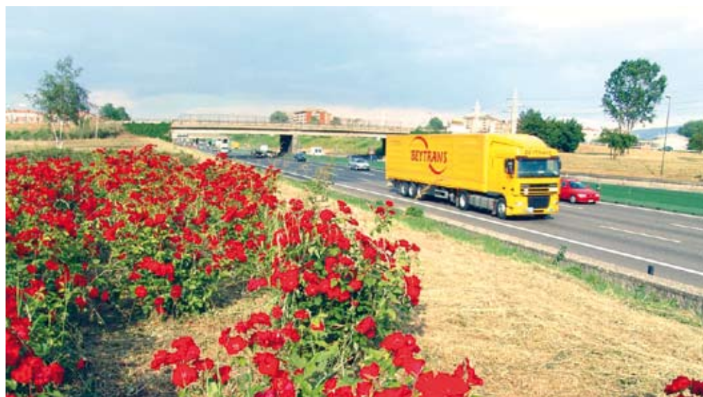
Vista della Tangenziale Nord esistente nei pressi di Venaria
