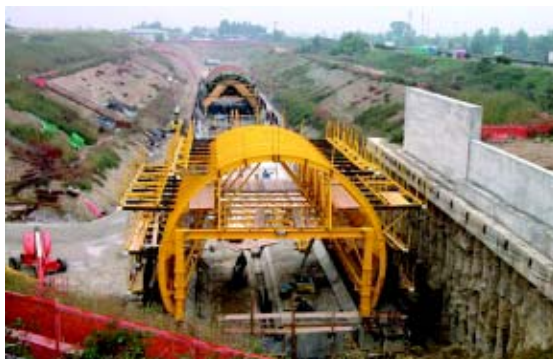
Lavori alla galleria Somaglia nell'ottobre 2003
