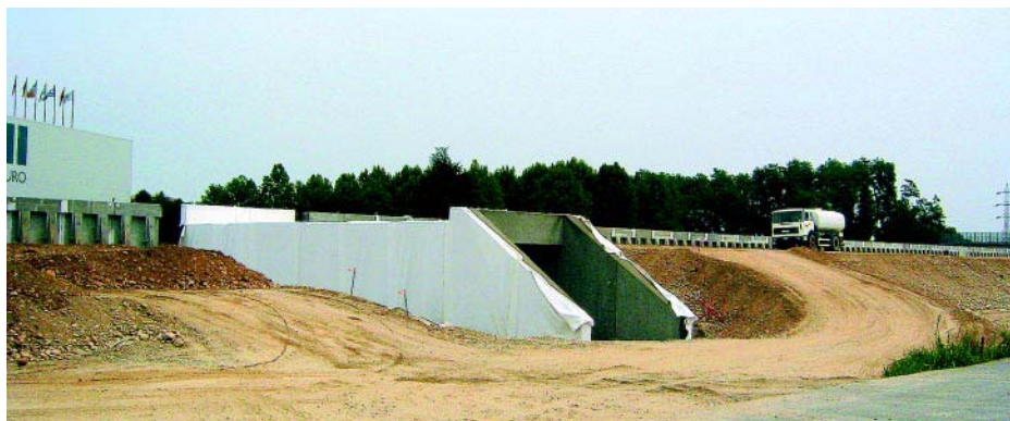
Uno dei 420 tombini idraulici lungo la linea AV Torino-Novara
