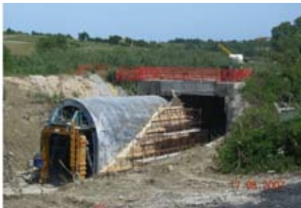
Particolari dei lavori di allargamento della galleria Castellano e della costruzione del suo imbocco sud
