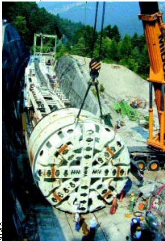
La fresa della galleria di Monte Zucco
