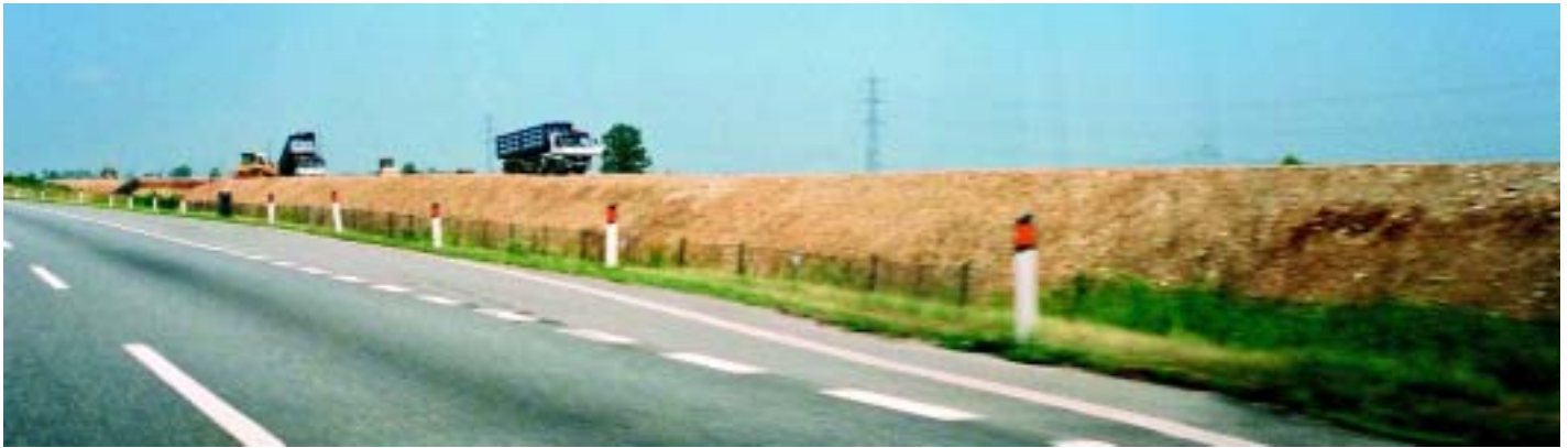
Costruzione di un rilevato della Torino-Milano
