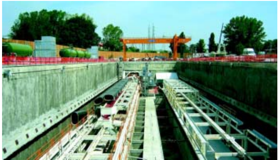
Inizio dello scavo per l'attraversamento AV del nodo di Bologna
