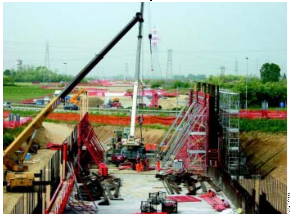
La galleria artificiale Rondissone della Torino-Novara
