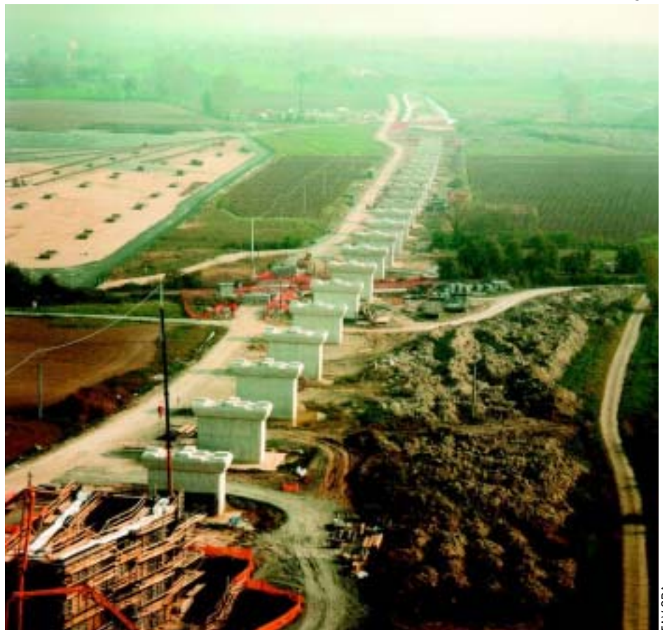
Il cantiere del viadotto La Piovana 2 della linea AV Milano-Bologna
