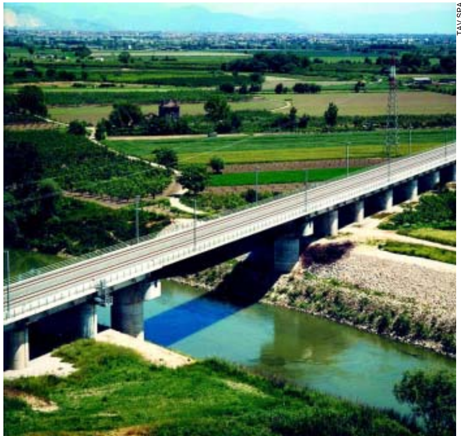
Veduta del viadotto Volturno della linea AV Roma-Napoli.
