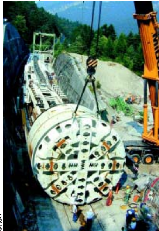
La fresa della galleria di Monte Zucco
