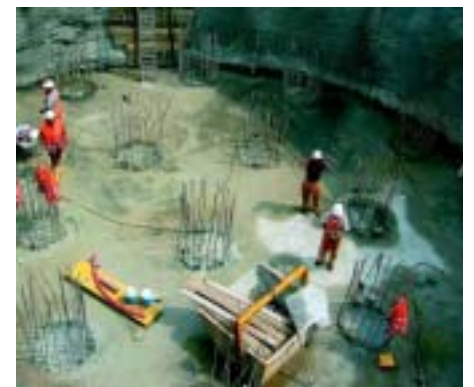
Fondazione per il viadotto sulla Dora Baltea, lungo la linea AV Torino-Novara
