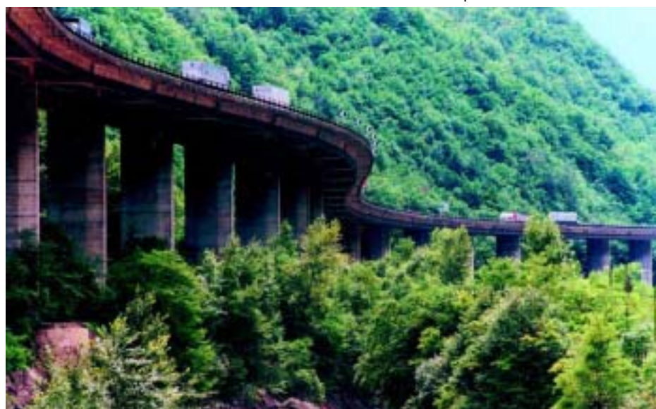
Particolare del Viadotto Campodasso dell'A22 del Brennero
