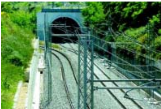
Galleria Vasto lato nord
