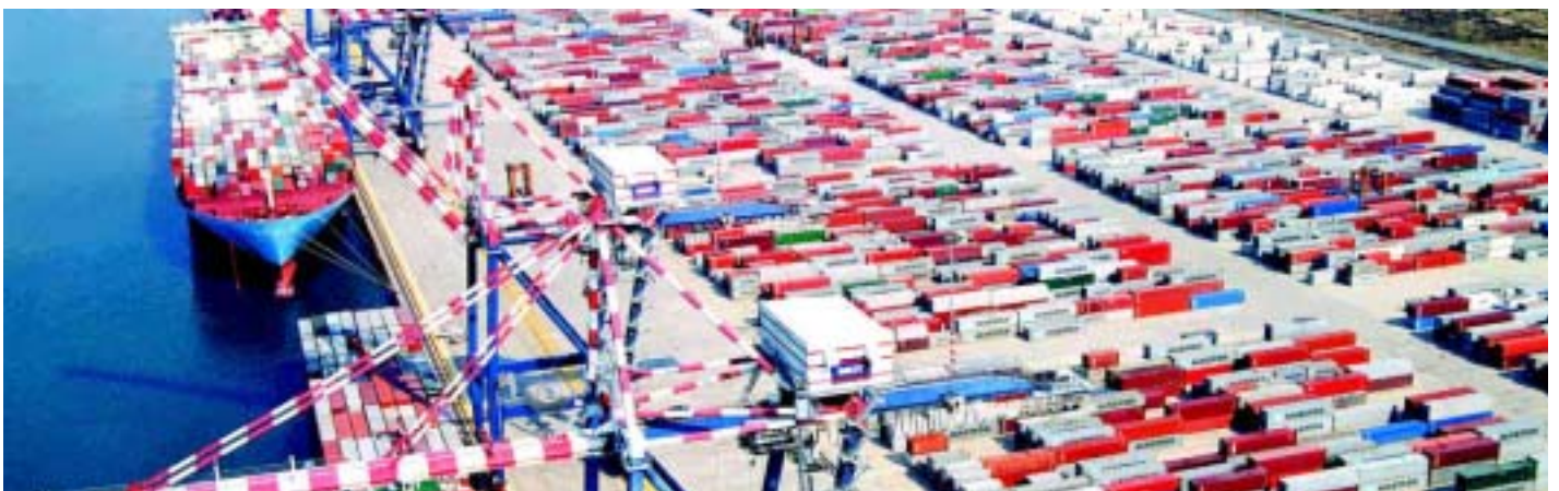
Particolare del porto di Gioia Tauro
